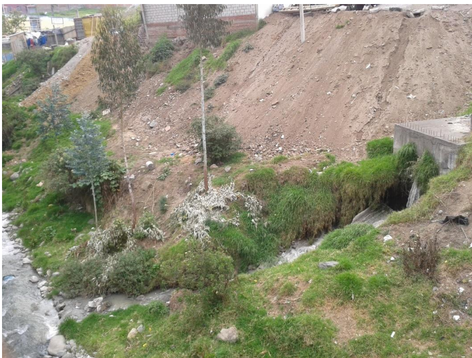
Descarga 3, puente vía a Riobamba.
