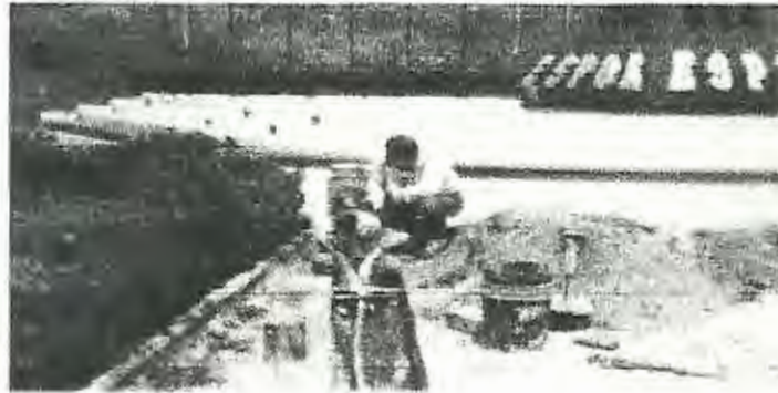
FIGURA 1.3.2 REMOCIÓN DE ADOQUINES
