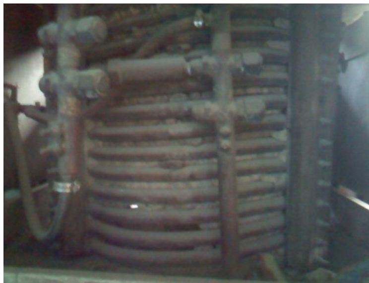
Figura 1.2: Foto de la Bobina de Inducción de cobre electrolítico.
