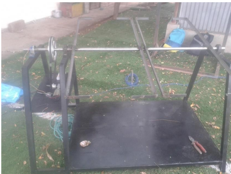
Figura 4.5: Base de los Paneles Fotovoltaicos.
