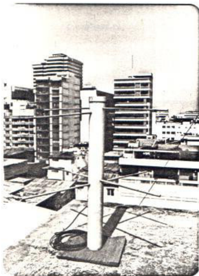
FOTO 1 Antena torniquete para 2 m perteneciente a la estación terrena de HC2CEV.
