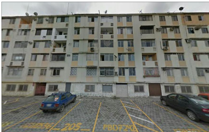
Figura 3.3: Foto panorámica – Bloques de la Atarazana
