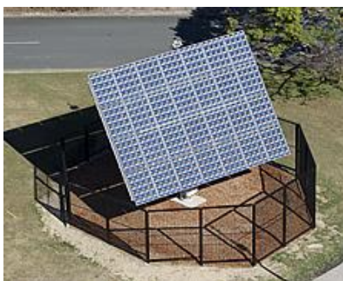
Figura 3.12 Paneles seguidores en un campus [47]
