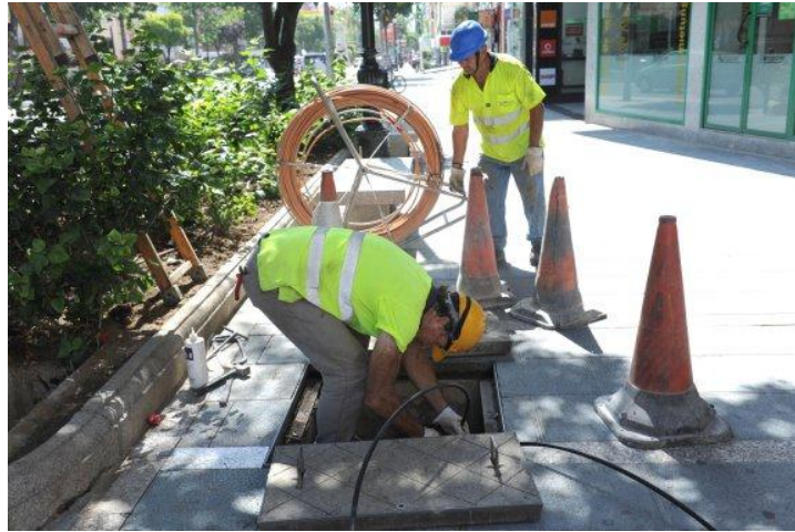
Figura 1.1 Tecnicos colocando fibra en campo
