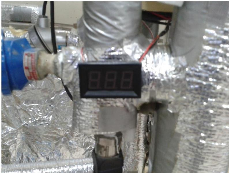
**Figura 1.2 Indicador a siete segmentos del sensor sonda Pt100 instalado en la tubería de vapor.**
