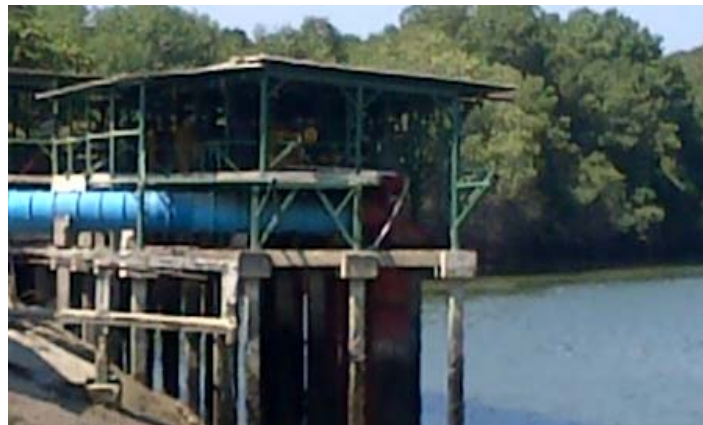
Figura 22 Estación de bombeo camaronera Ecuacultivos s.a.
