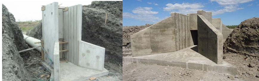
Figura 20 Compuertas de salida de piscinas camaroneras
