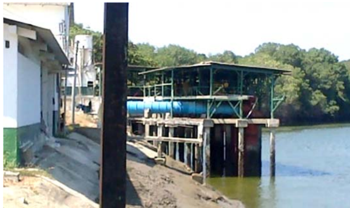
Figura 19 Estación de bombeo de camaronera Ecuacultivos s.a.
