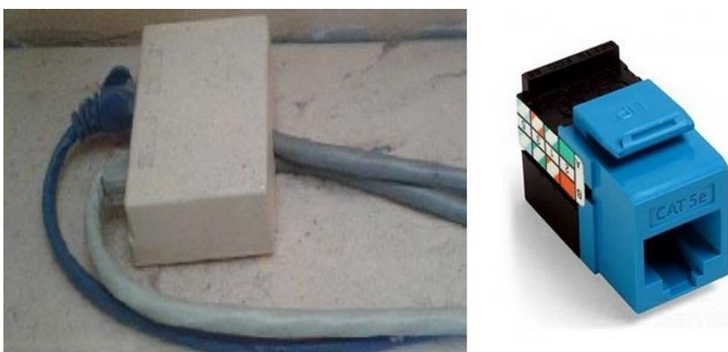
Figura 1.7: Roseta para conectores RJ45 cat. 5e instalada en el laboratorio de audiovisual
