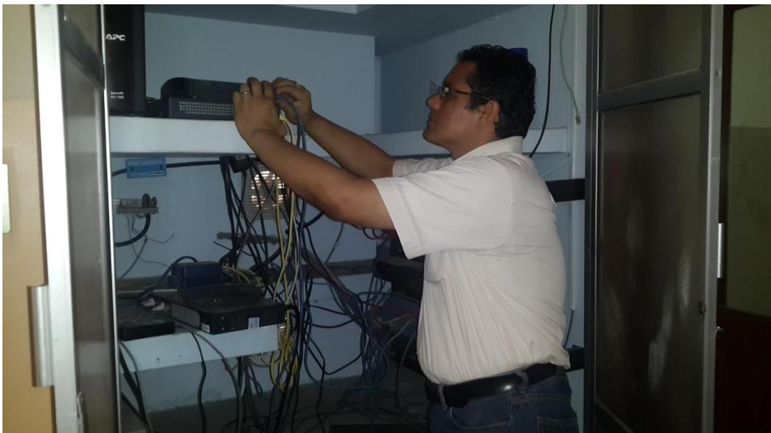
Figura 2: Conexión del enrutador suministrado por el proveedor Claro
