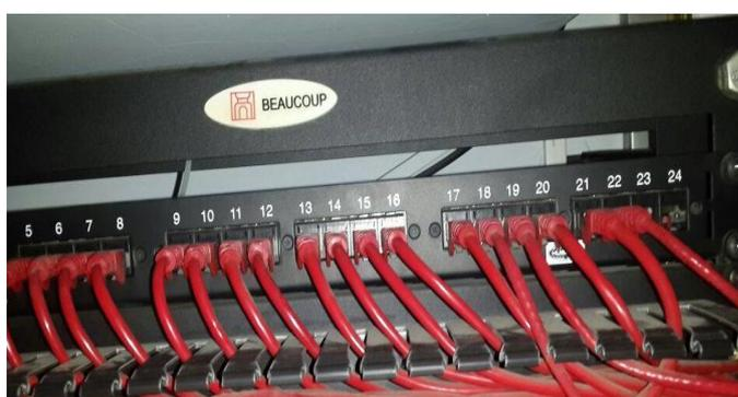
Figura 1.6: Panel de conexiones implementado sobre rack Beaucoup
