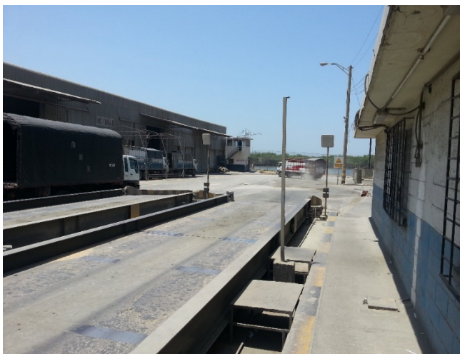
Figura 3.4 Antenas RFID en básculas
