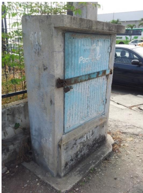
Figura 4.15: Inspección de la Ciudadela Santa Leonor
