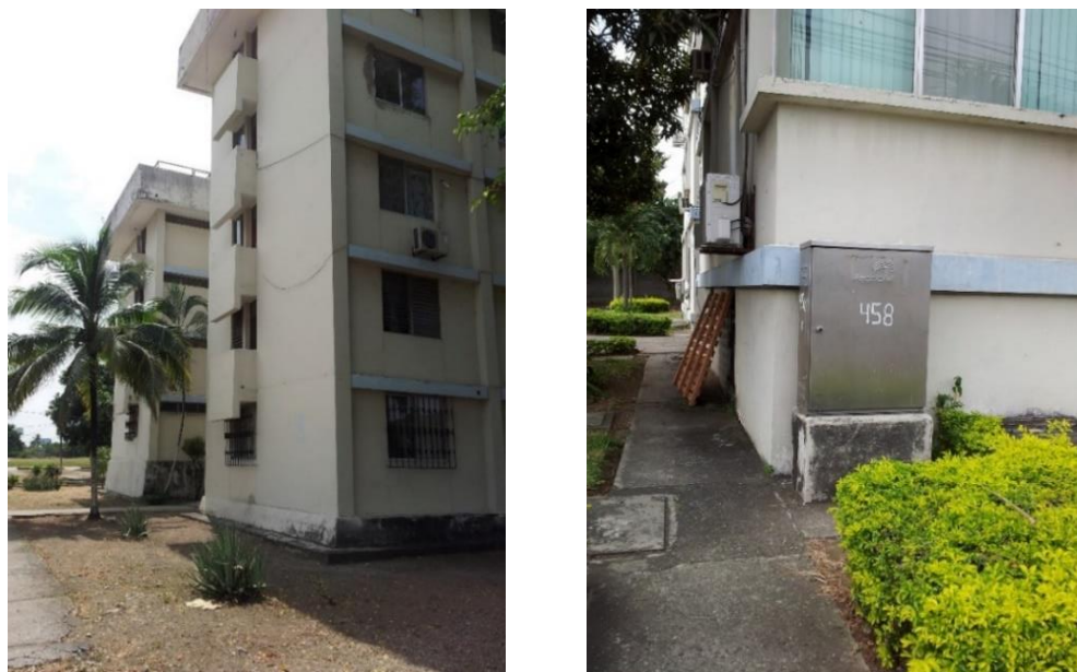
Figura 4.13: Inspección de los Bloques de la FAE
