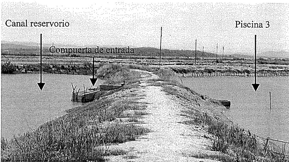
Figura 13: Estado del muro entre el canal reservorio y la piscina 3 al momento de la compra de la camaronera COFIMAR.
