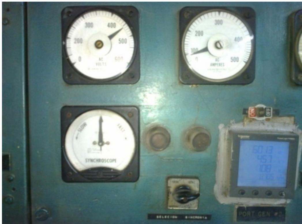
Figura 1.16 Elementos existentes en sistema de sincronización. Fuente: [4]
