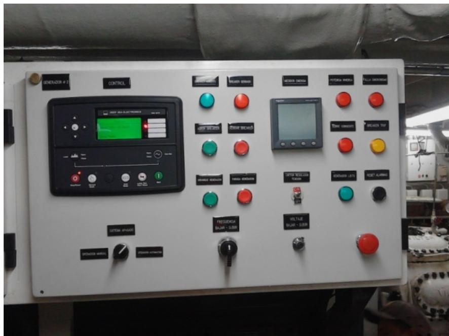
Figura 1.19 Un cuadro de control del sistema de sincronización. Fuente: [4]
