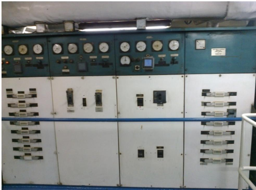
Figura 1.13 Tablero de sincronización manual. Fuente: [4]
