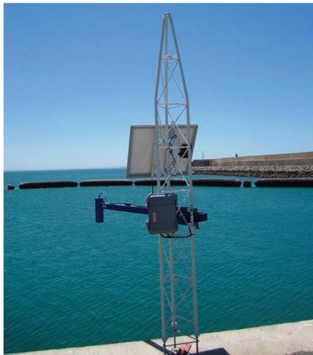
**Figura 3.11: Sistema de energía solar para mareógrafo instalado [34]**
