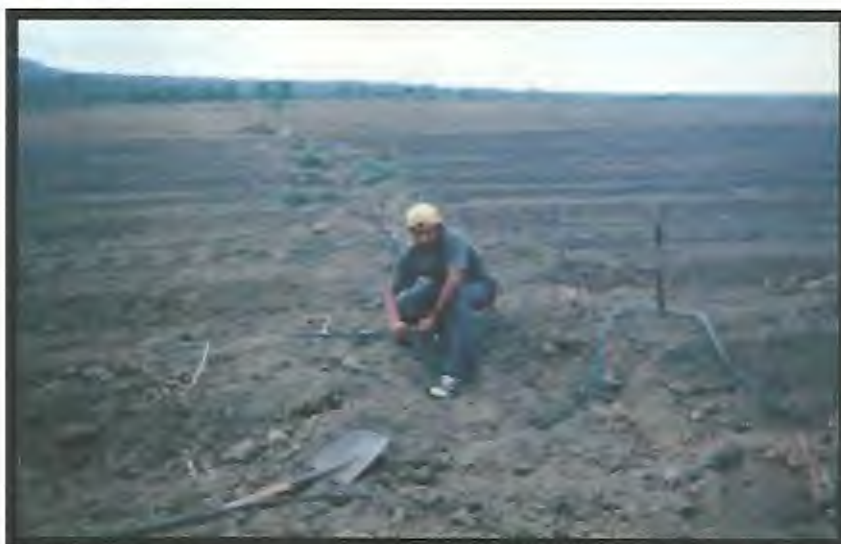
Foto. 3.- Tendido de las tuberías del sistema de riego por goteo.
