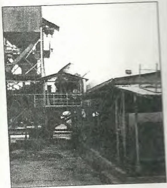
FOTO No. 14 ELABORACION DE HORMIGÓN. TAMBOR MEZCLADOR
