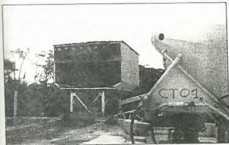
FOTO No. 5.- ALIMENTACION TOLVA DE AGREGADOS. TOLVA DE RECEPCION
