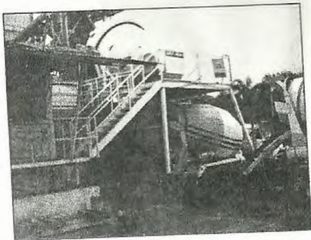
FOTO No. 15 CARGADO DE MIXERS
