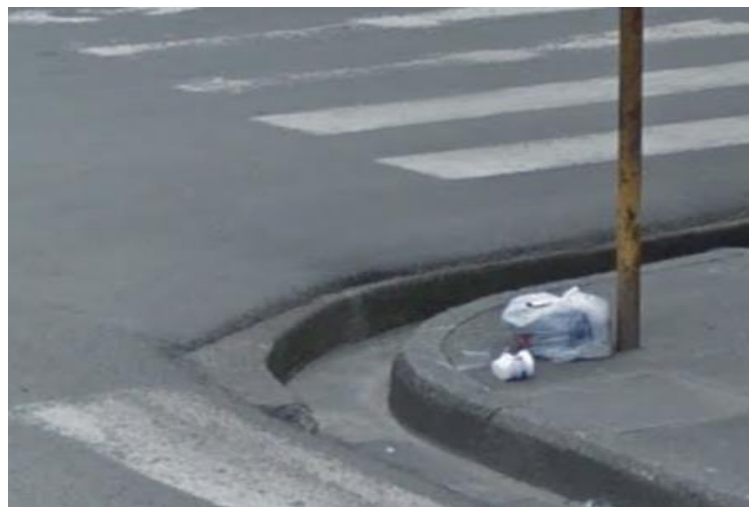
Fig. 3.7. Presencia de canaletas de hormigón para el direccionamiento de aguas pluviales.
