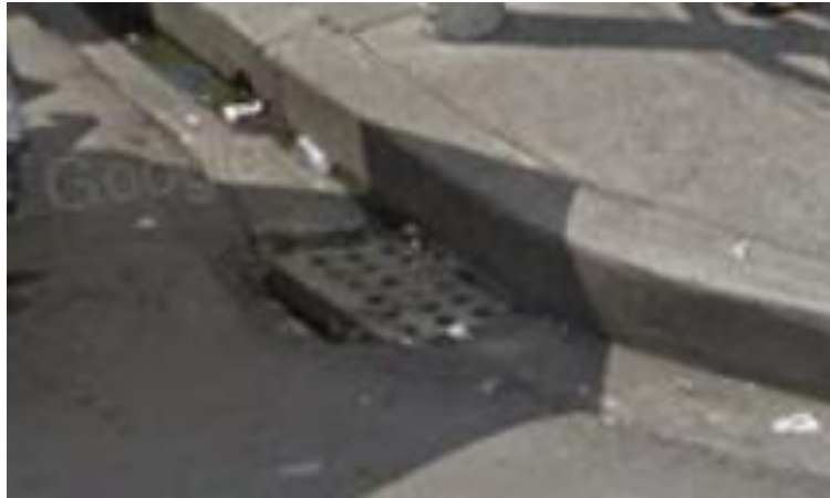
Fig. 3.15. Presencia de un punto de drenaje en la intersección de las calles 24 de Mayo y Epicachima. Dicho punto posee una tapa de hormigón y sus respectivas canaletas de drenaje.
