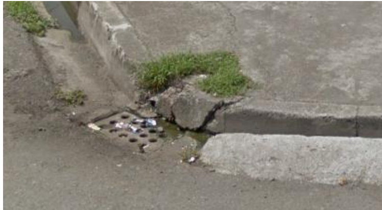
Fig. 3.17. Presencia de un punto de drenaje en la intersección de las calles 24 de Mayo y Coronel Luis Vargas. Dicho punto posee canaletas de direccionamiento de aguas pluviales.
