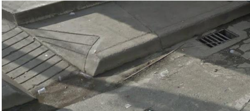
Fig. 3.9. Solución entre la rampa de la acera, las canaletas y el punto de drenaje pluvial. Fuente: Tomada por el autor
