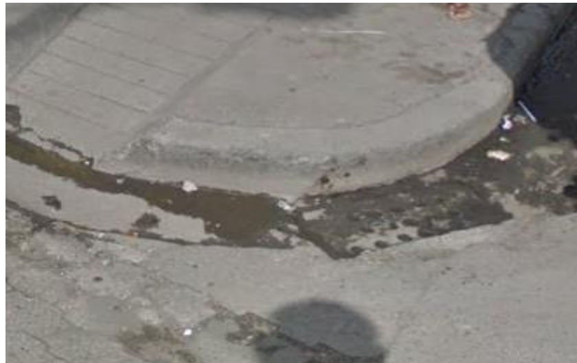
Fig. 3.10. Visualización de punto de drenaje pluvial (hormigón) y canaletas de direccionamiento de aguas pluviales en la intersección de las calles 24 de Mayo y Rocafuerte. Fuente: Tomada por el autor
