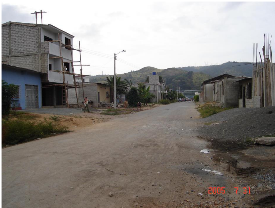
FOTO No. 3 Tipo de viviendas (sector junto a Puerto Azul entre la vía Perimetral y la Autopista Guayaquil-Salinas))
