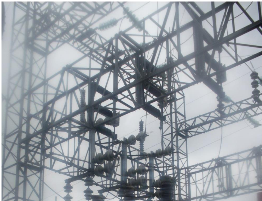
Figura 1.5 Seccionador Tripolar
