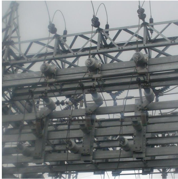
Figura 1.12 Cuchillas seccionadoras monofásicas
