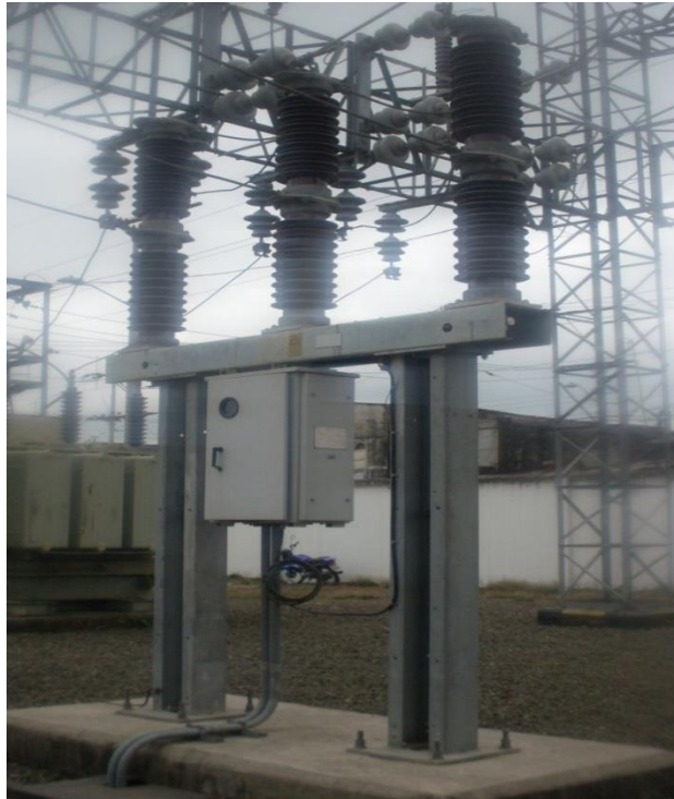
Figura 1.6 Interruptor en gas (SF6) a 72.5 KV
