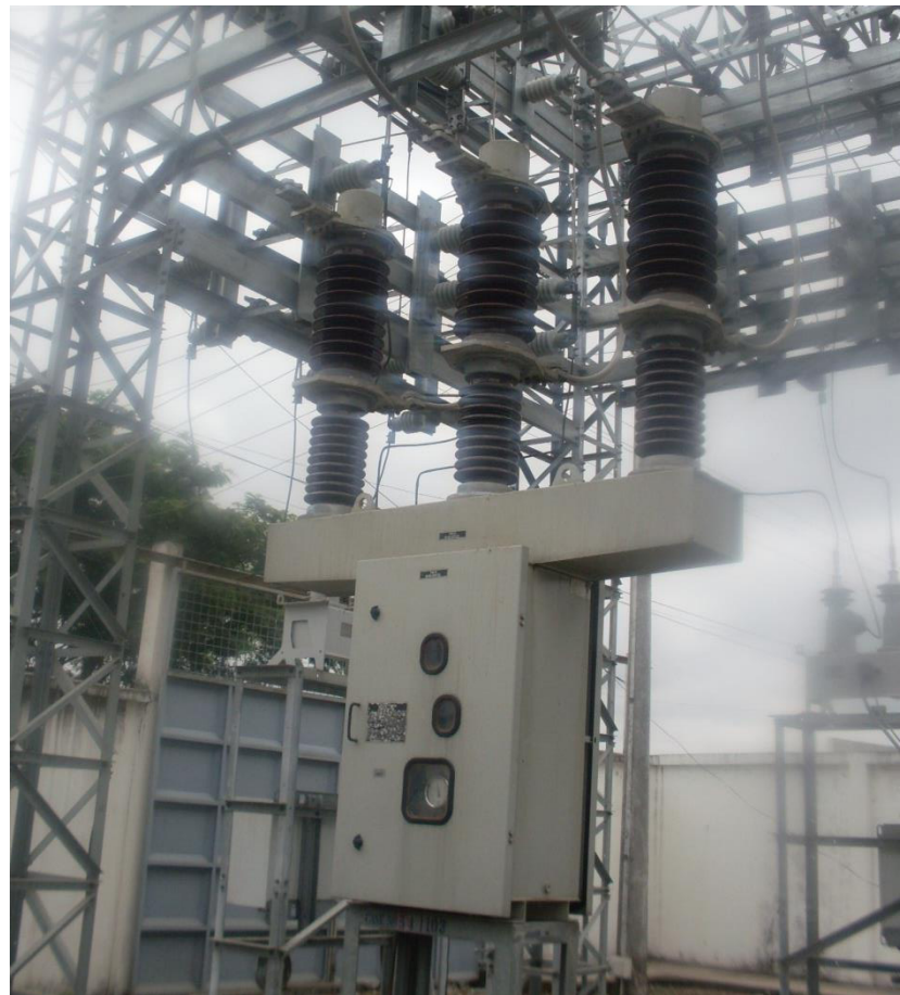
Figura 1.8 Interruptor en gas (SF6) a 36 KV
