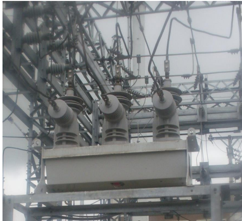
Figura 1.11 Reconector de la alimentadora
