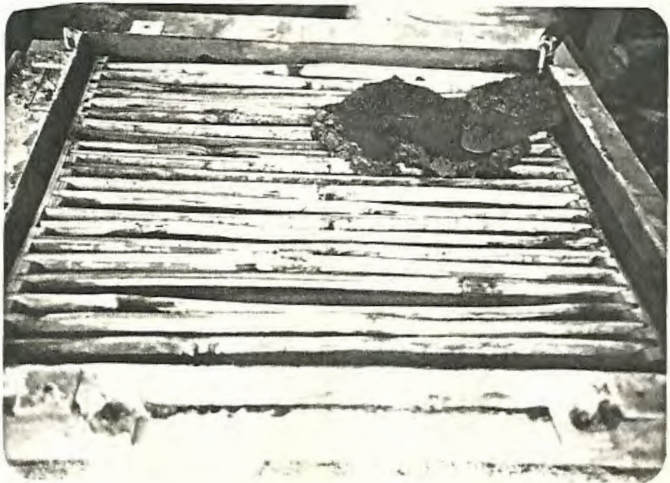
FIG. 38.- LLENADO CON MORTERO
