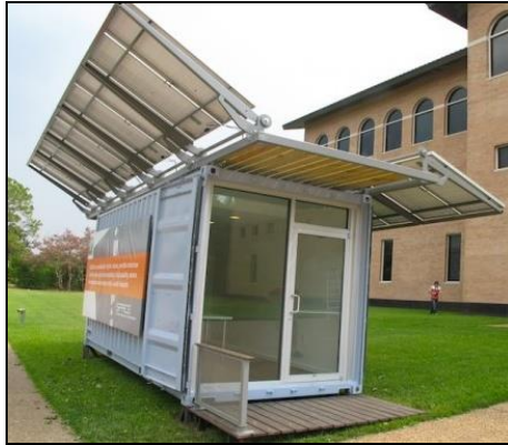
Figura 3.9 Contenedor con paneles solares en su cubierta y en las paredes - http://www.solarenergos.cl/media/k2/galleries
