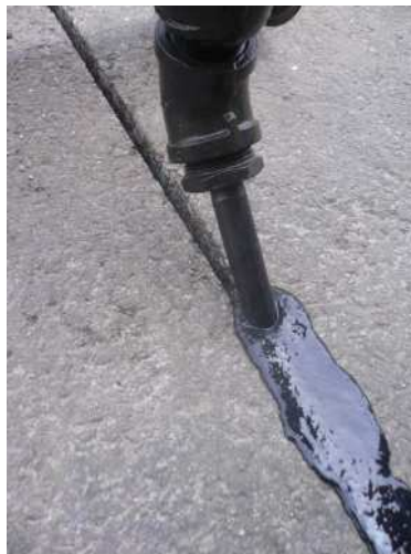
Fig. 4.20 sellado de la microzanja con asfalto líquido
