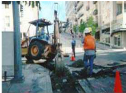
Fig. 4.15 Tendido de fibra tradicional
