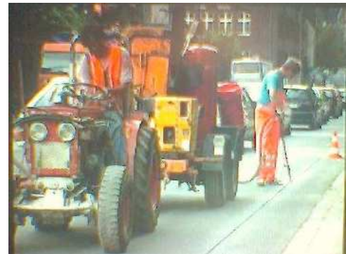
Fig. 4.16 Tendido de Microducto
