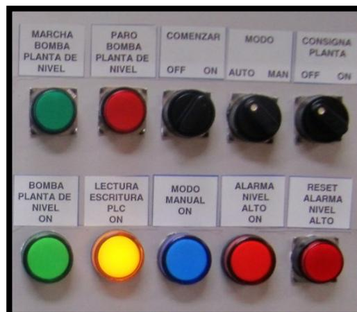
Figura 3.17 Selectores, pulsadores y luces piloto de la Planta de Nivel
