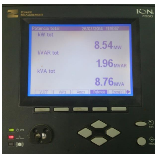
Figura 1.15 Medidor totalizador
