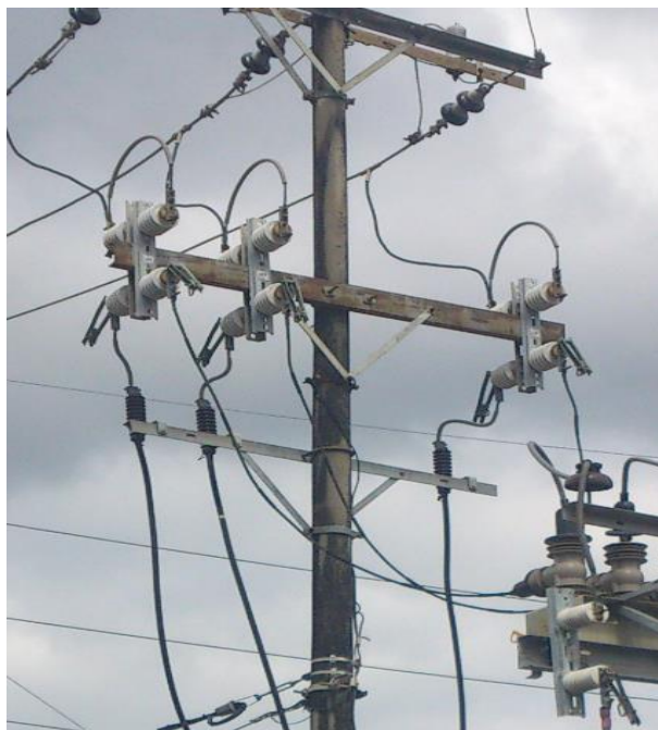
Figura 1.13 Cuchillas seccionadoras
