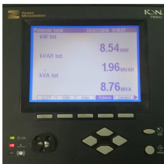
Figura 1.15 Medidor totalizador
