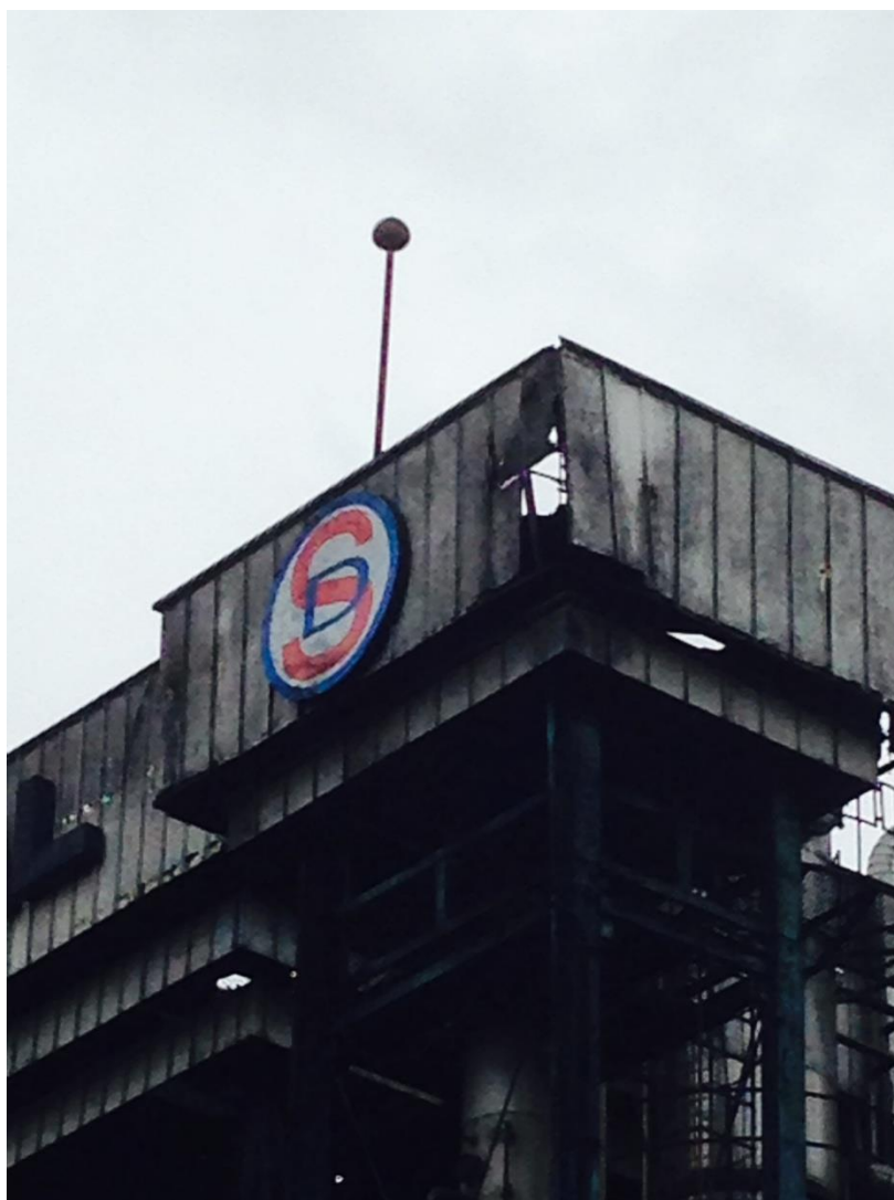
Figura 9. Pararrayos instalado en torre de fraccionamiento
