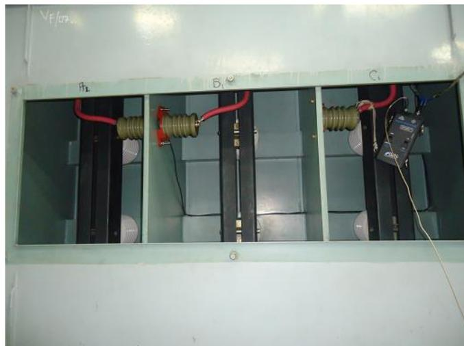
**Figura 1.10. Sensores del sistema generador eléctrico TV2**
