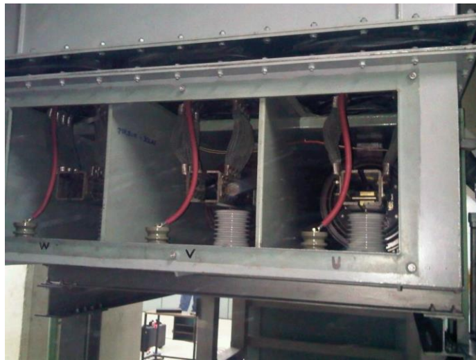
Figura 1.9. Sensores de máquina generador eléctrico TV2
