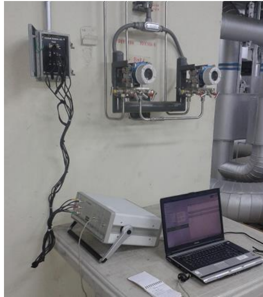
Figura 1.7. Conexión del equipo PDA PREMIUM
