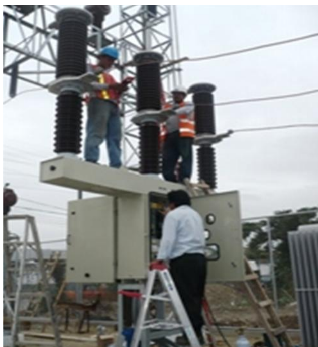
Figura 9. Montaje de interruptor de fuerza de 69 KV.
