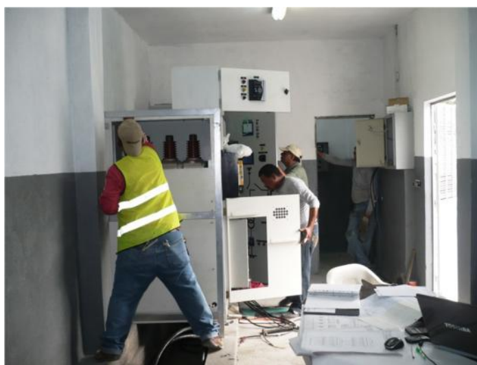
Figura 13. Montaje de celdas de 13.8 KV.
