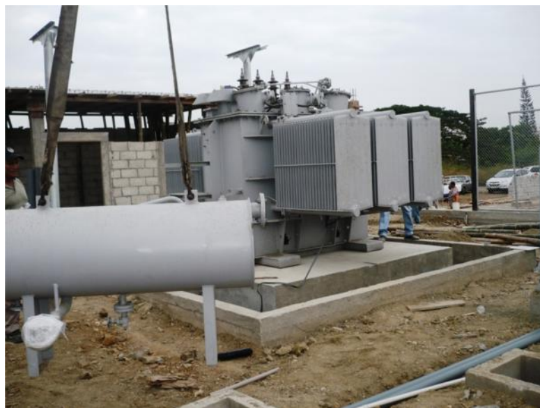
Figura 7. Armada y montaje del transformador de poder
