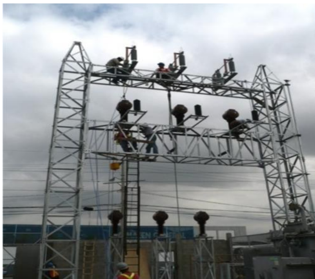
Figura 10. Montaje de equipos en pórticos de 69 KV.
