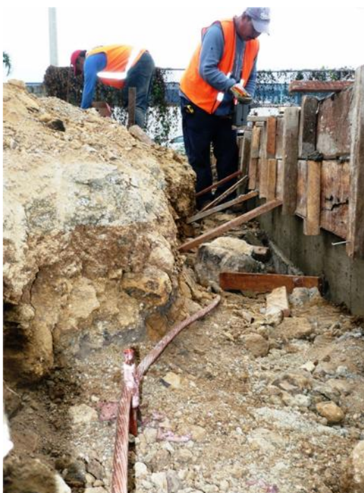
Figura 2. Instalación de la malla de tierra
