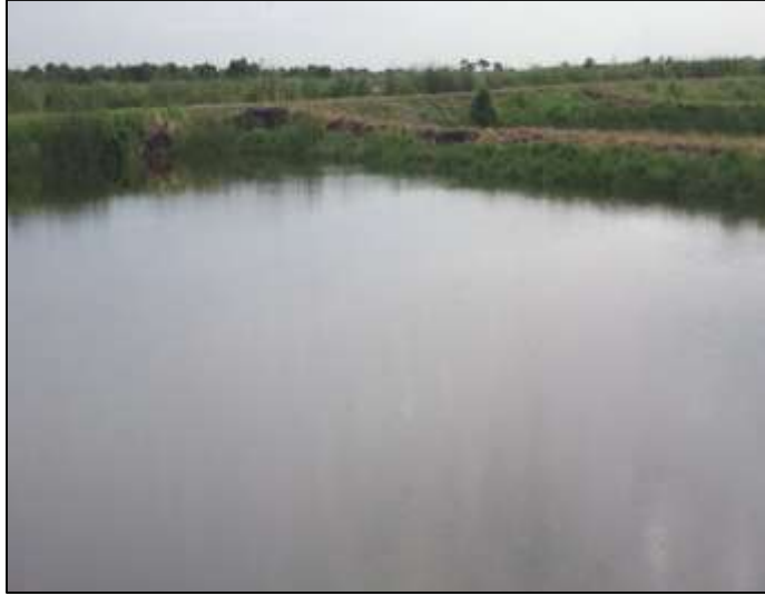
Anexo A. Piscina de adaptación con exceso de vegetación
