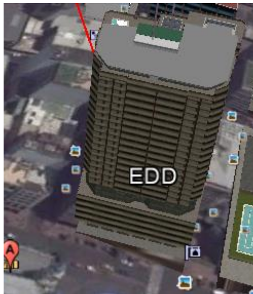
Figura 21. Edificio Plaza San Francisco.
