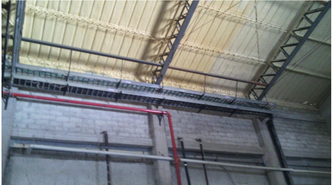
Figura 2.3: Canaleta portacable tipo rejilla
