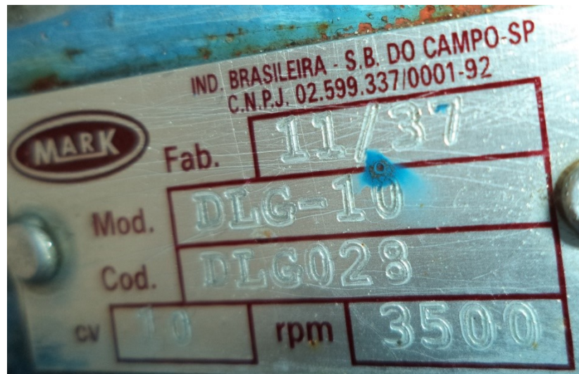
Fig. 3.5: Datos de placa de la bomba de la red de agua del chiller.
