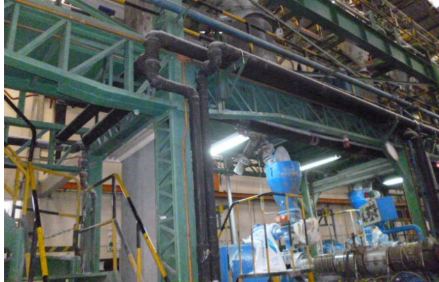
Fig. 4.4: Red de agua helada, llegada y retorno de línea de producción XT-21.
