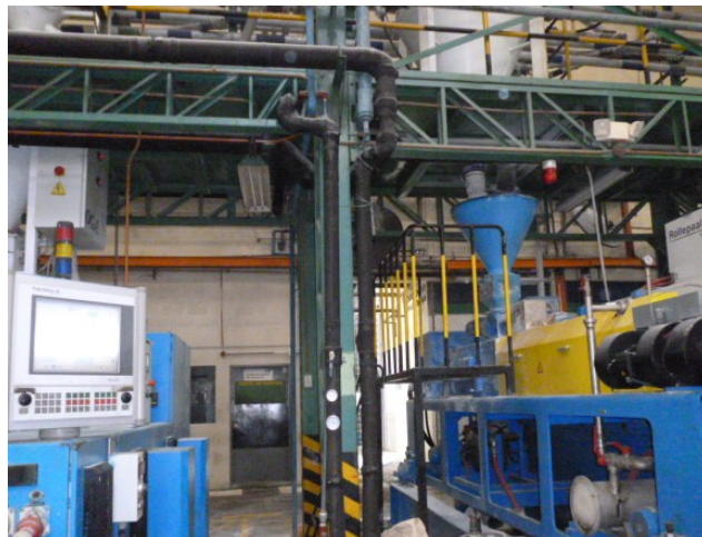
Fig. 4.6: Red de agua helada, llegada y retorno de línea de producción XT-35.
