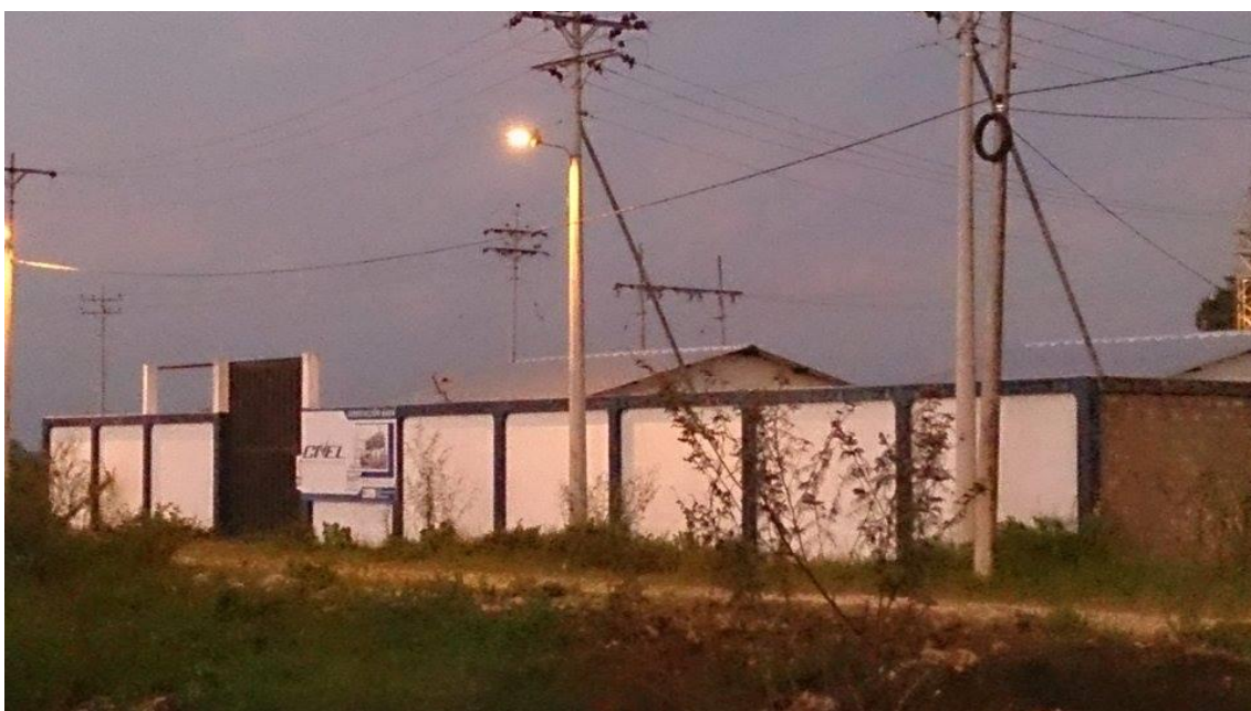
Figura 1. 3: Vista exterior de la Subestación Baba
