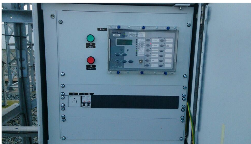
Figura 1. 13: Controlador SIEMENS Reyrolle 7SR224
