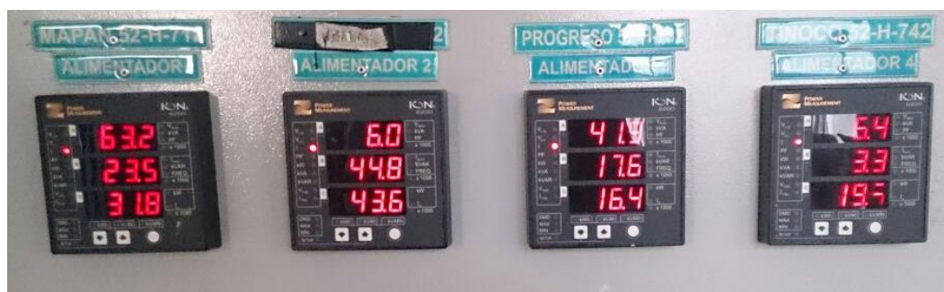
Figura 1. 20: Medidor de energía ION6200
