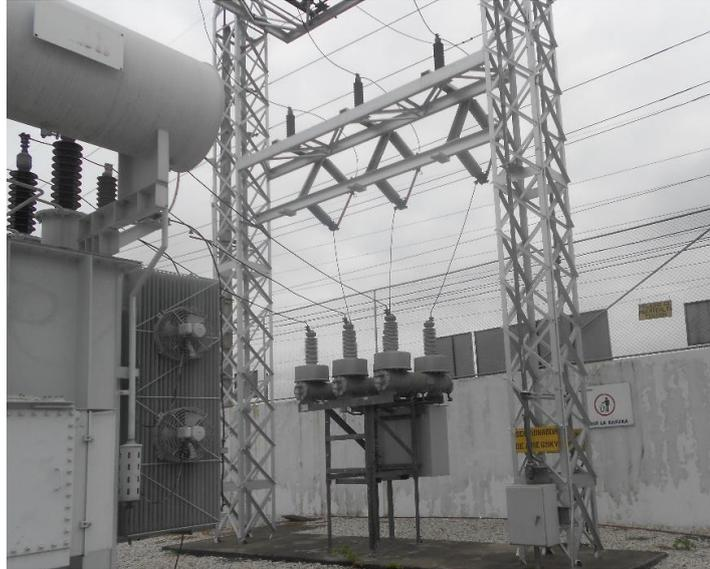
Figura 1.3: Estructura de 69kv y Disyuntor.
