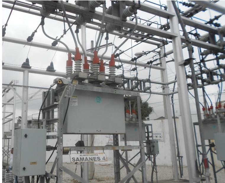
Figura 1.5: Estructura de Seccionadores Alimentadora Samanes 4.
