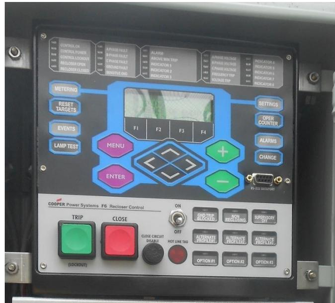
Figura 1.6: Panel de control del Reconectador de cada alimentadora.
