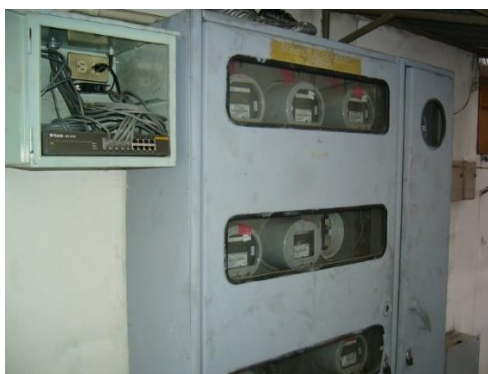
FIGURA 4.4. RED LAN MEDIDORES Elaborado por: Eddie Calderón M., 2005
