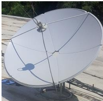
Figura 2.1 Antena de Foco Primario o Centrado.
