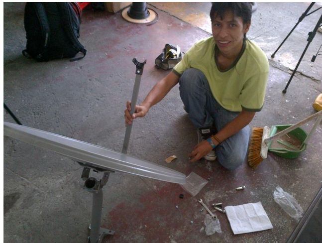
Figura A.8 Fijación de la Antena al Suelo.
