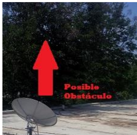
Figura A.21 Posible Interferencia de Señal debido a que las Hojas del Árbol son Obstáculos.
