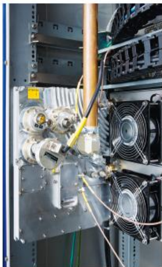
Unidad de acoplamiento 8 en 1, para acoplar dos amplificadores R&S*PMU901.
