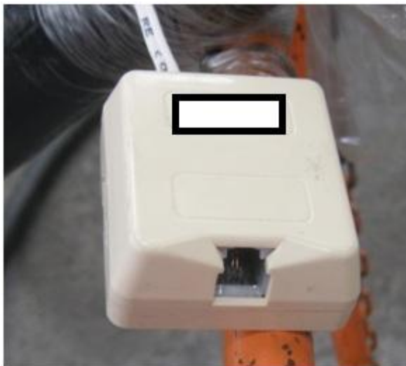
Figura 3.29 Roseta Telefónica.
