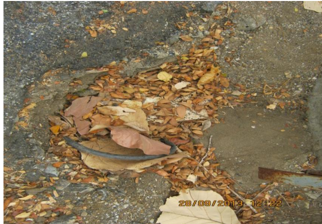
Figura 3.17 Cableado Subterráneo Central Lago Capeira [18]
