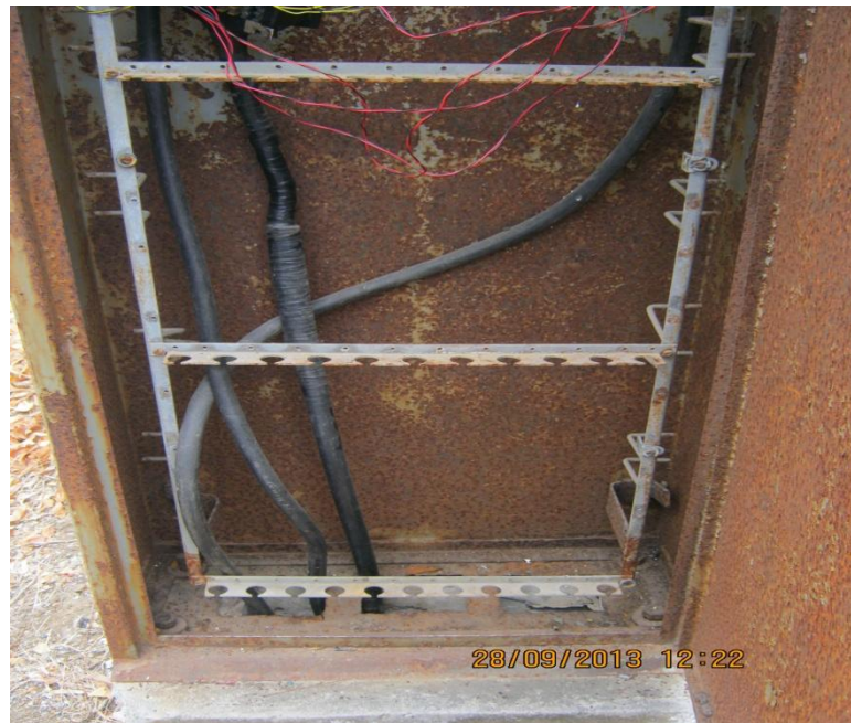
Figura 3.25 Armario 02 de Red Planta Externa Lago Capeira [18]
