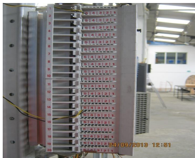
Figura 3.14 Bloques De Conexión
