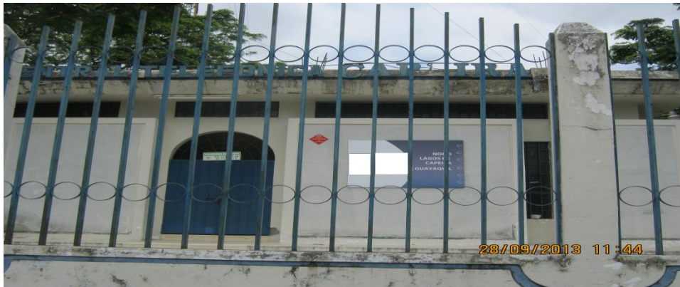
Figura 3.4 Central Telefónica Lago Capeira
