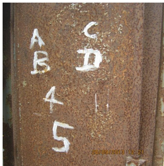
Figura 3.24 Etiquetamiento de Regletas en Armario 02
