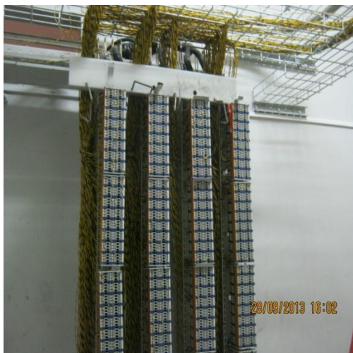
Figura 3.6 MDF Central Lago Capeira (Vista Frontal Superior)
