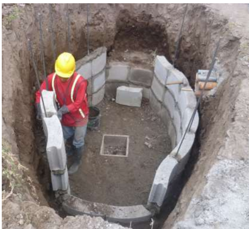
Figura 4.13: Construcción de un pozo de entrada a la central [21]
