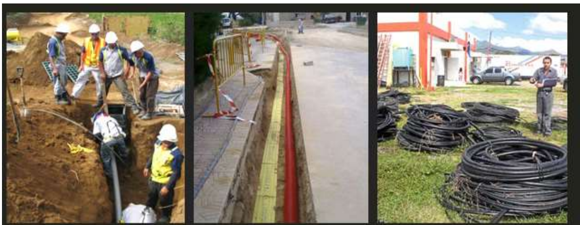
Figura 4.12: Construcción de red de planta externa [20]
