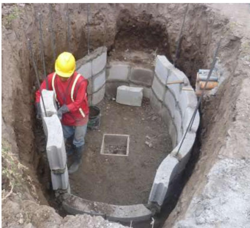
**Figura 4.13: Construcción de un pozo de entrada a la central
