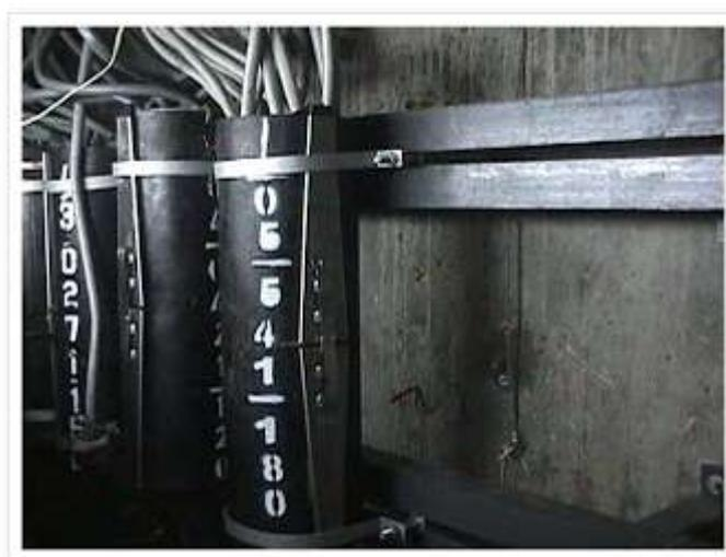
**Figura 4.11: Encapsuladores para Cables Telefónicos [19]**
