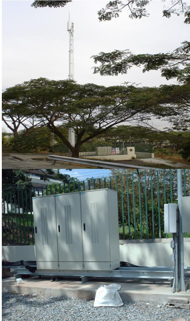
**Figura 1.13 Estación base GSM (ESPOL)**
