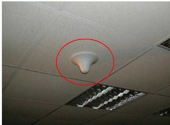
Figura 3.10 Antena omnidireccional montada en el cielo falso
