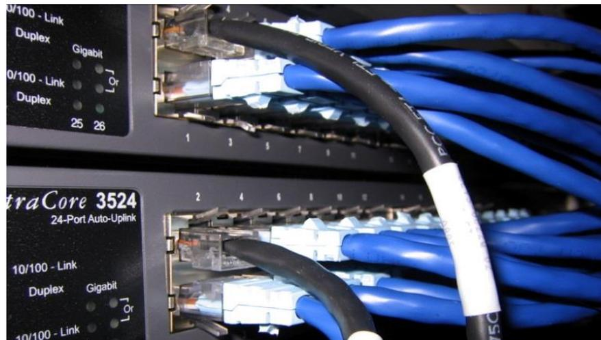
**Figura 2.3** Interconexión de switches
