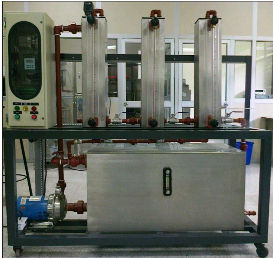
Figura 1.2. Vista Frontal de la Planta
