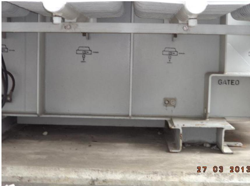
**Figura #1. 13** Puntos de puesta a tierra del tanque
