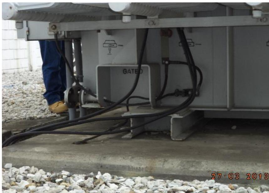
**Figura #1. 14** Puntos de puesta a tierra del tanque (continuación).
