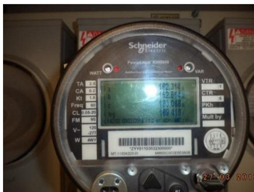
**Figura #1. 28** Medidor totalizador
