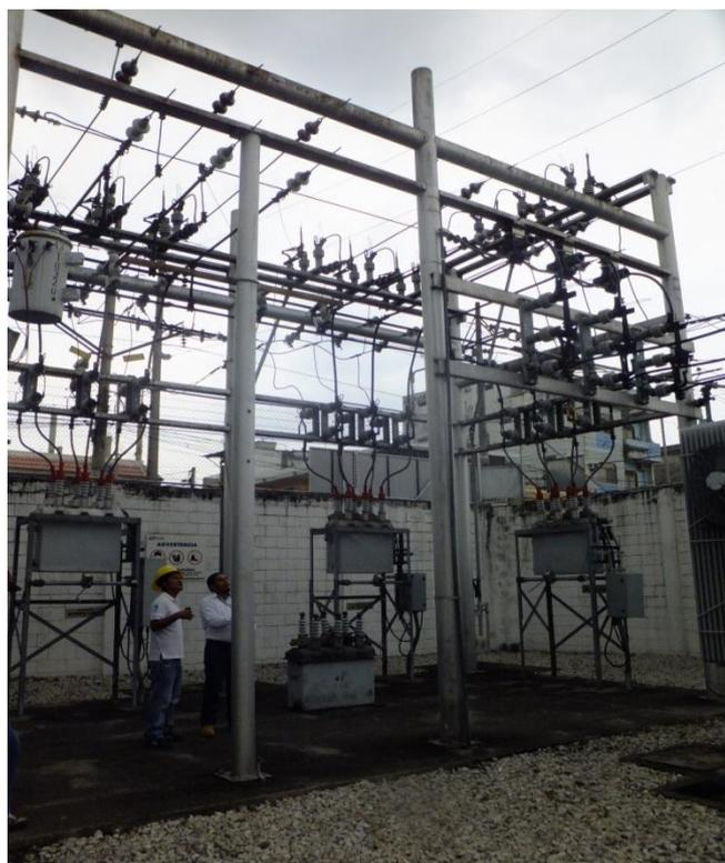
**Figura #1. 21** Estructura y componentes del patio de 13.8kV.
