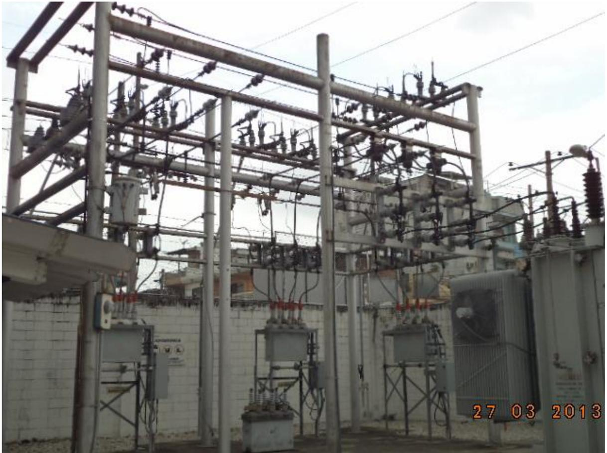
**Figura #1. 4** Aparamenta del patio de 13.8kV.
