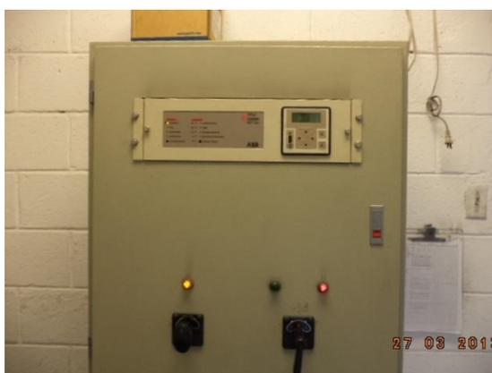
**Figura #1. 29** Tablero del TPU 2000R
