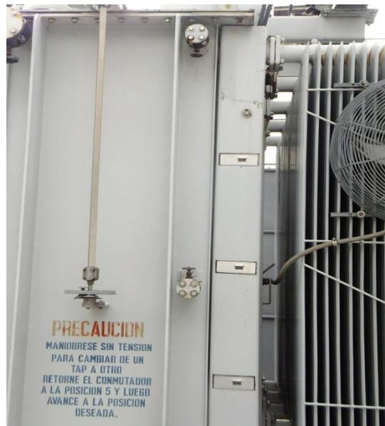
**Figura #1. 15** Cambiador de derivaciones sin carga.
