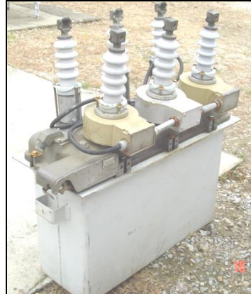
Fig. 2.2 Reconector para Alimentadora
