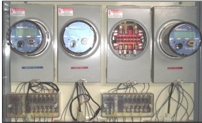
Fig. 4.14 Medidores por cada alimentadora
