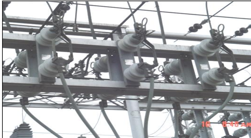
Fig. 4.11 Cuchillas Seccionadoras de Alimentadoras
