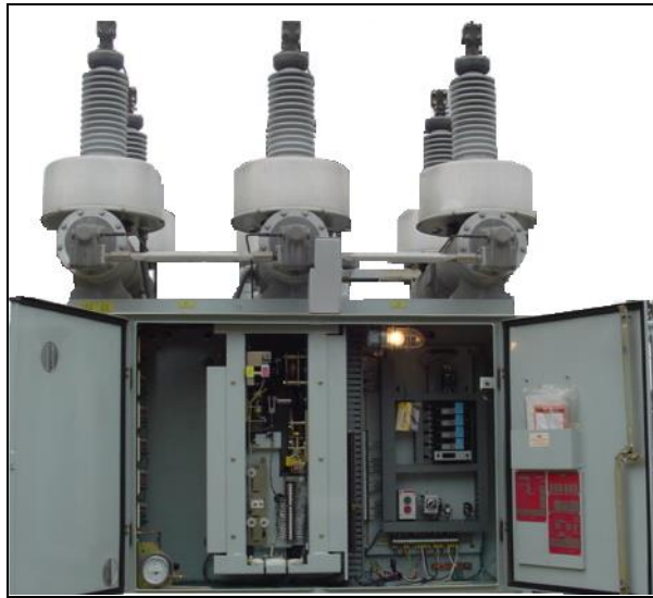
Fig. 4.15 Interruptor en gas SF6 (GCB)
