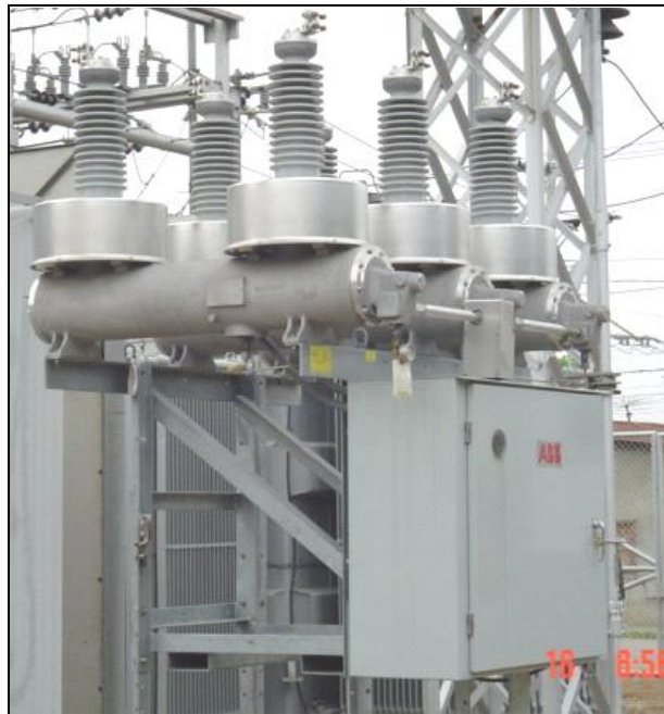
Fig. 4.5 Interruptor en gas SF6 (GCB) de Mapasingue 1
