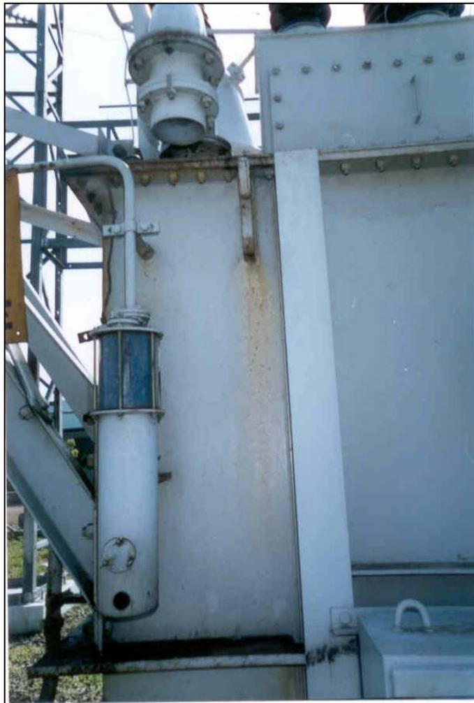
FIGURA 1.38. SECADOR DE SILICA GEL MONTADO EN UN TRANSFORMADOR.
