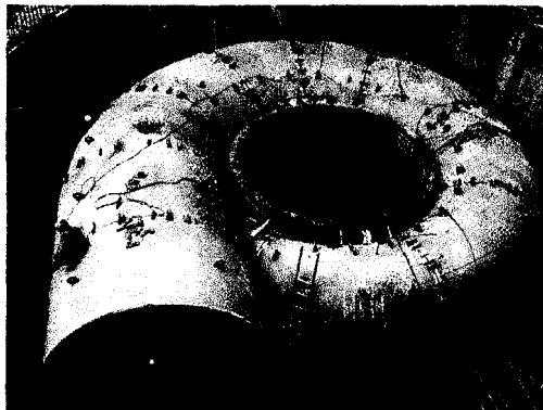
Fig. 1.8: Caja Espiral en su Proceso de Montaje.
